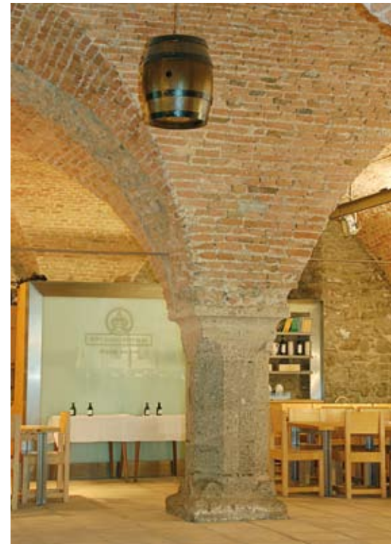
Foto 2: Der Aquapol „TURBO“ in der Vinothek im Stift Klosterneuburg wurde in einem Weinfass „getarnt“ montiert, das dann aufgehängt wurde.
